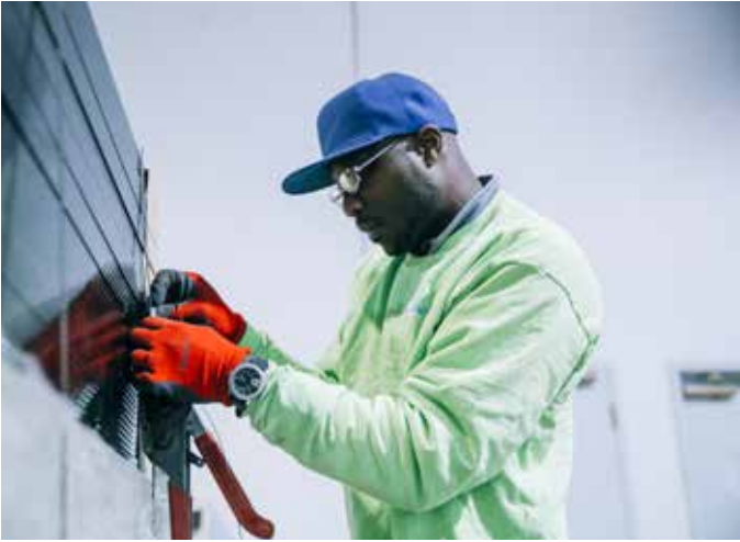
Un trabajador de Solar Liberty instala paneles solares en Buffalo, Nueva York. El reemplazo del TLCAN debería fomentar las inversiones que creen buenos empleos y la energía limpia. Además, no debería ofrecer incentivos para invertir en combustibles fósiles u otros negocios que sean incompatibles con la economía de energía limpia. Foto: Stephen Yang
